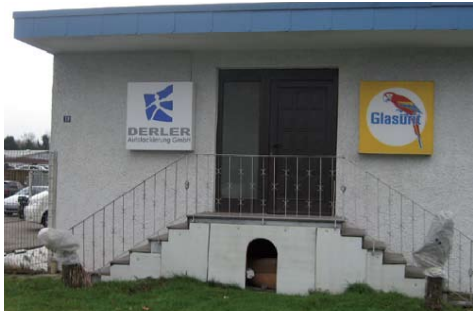
Das Bürogebäude der DERLER Autolackierung GmbH in Rastatt.
