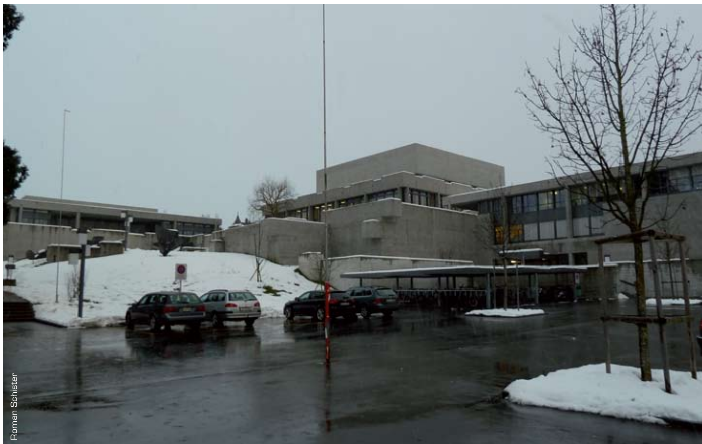
Hier soll das neue Provisorium gebaut werden
